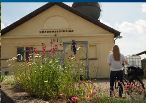
Umformerstation mit Kugelwasserturm
