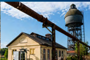
Umformerstation mit Wasserturm
